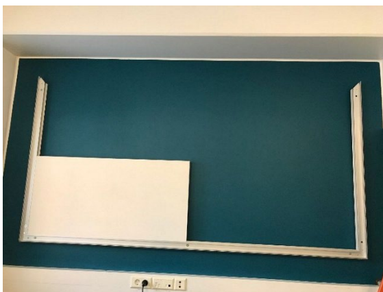
4. Aseta akustiikkalevy/-levyt kehyksen sisäreunassa olevaan uraan
