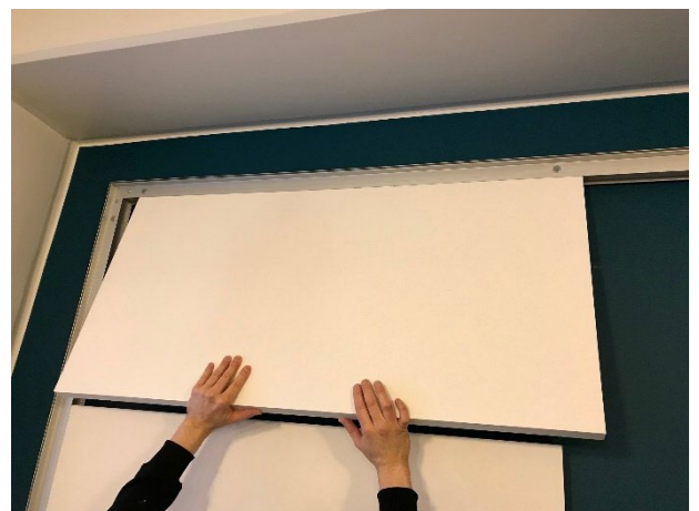
4. Aseta akustiikkalevy/-levyt kehyksen sisäreunassa olevaan uraan
