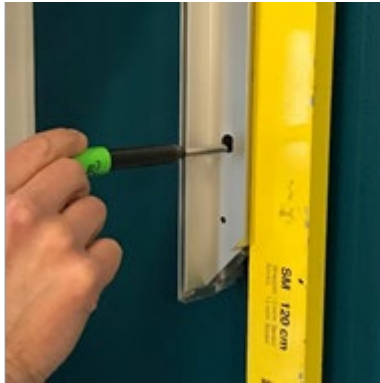
2. Merkkää ruuvien reiät ja poraa kehyslistaa seinään. Aloita vasemmasta sivu-listasta.
