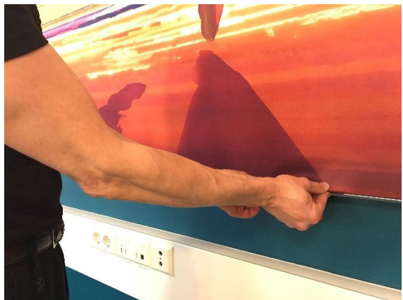
7. Aloita kankaan kiinnitys vasemmasta yläreunasta asettamalla silikoninauha kehykseen
