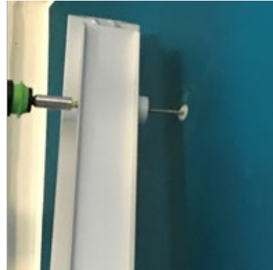
2. Merkkää ruuvien reiät ja poraa kehyslistaa seinään. Aloita vasemmasta sivu-listasta.
