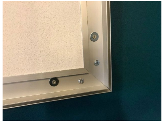
6. Kiinnitä loput listat ja kulmapalat
