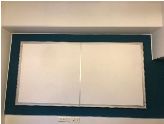
6. Kiinnitä loput listat ja kulmapalat
