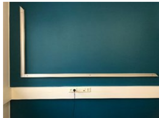
3. Aseta kulmapala ja kiinnitä ala-lista
