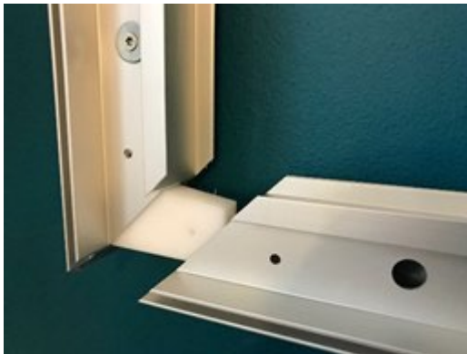
3. Aseta kulmapala ja kiinnitä ala-lista
